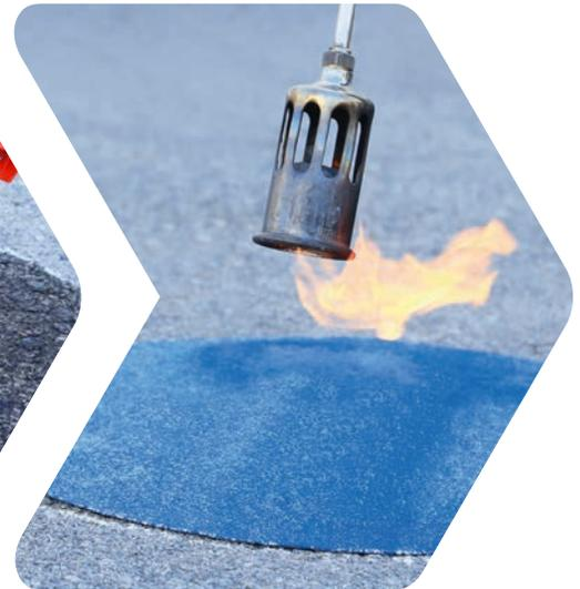
Use el soplete para calentar toda la superficie de la señalización termoplástica preformada hasta que empiece a burbujear.
