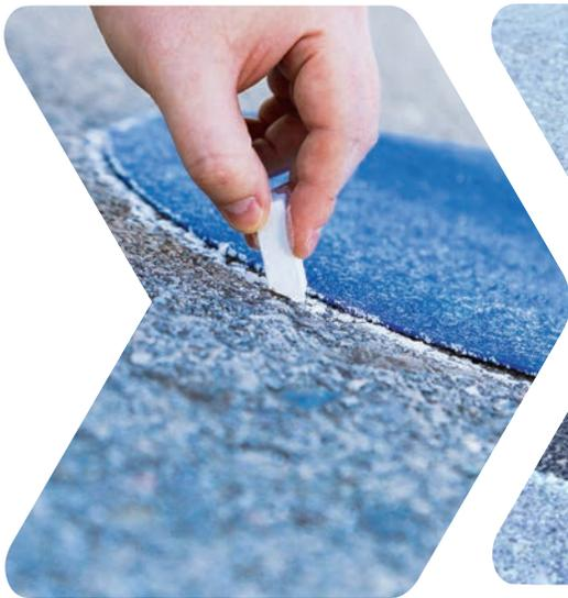
La zona que se va a demarcar debe estar limpia, completamente seca y sin polvo y aceite. Dibuje el contorno con tiza.
