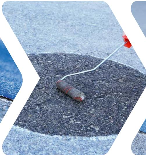
Si está fresco y húmedo, precaliente (seque bien) el sustrato. Si es necesario, aplique una imprimación y deje que se evapore.
