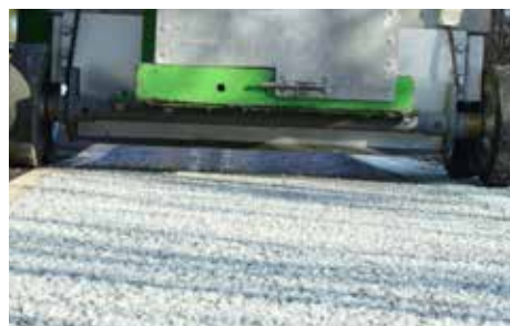
2-Komponenten-Nachleuchtplastik als Randmarkierung mit danebenliegender 2-Komponenten-Kaltplastik (transparent) mit Nachleucht-Aggregaten-Mix als Breitstrich
