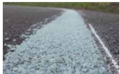
2-Komponenten-Kaltplastik (transparent) als Basisschicht mit nachgestreuten Light-Aggregates der Firma NighTec
