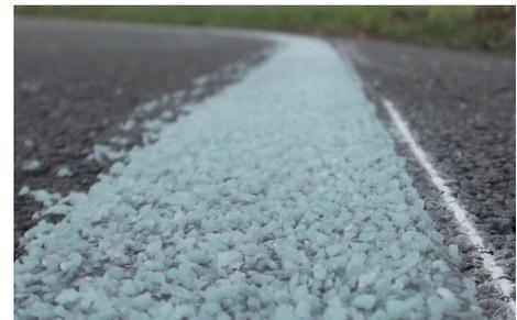
2-Komponenten-Kaltplastik (transparent) als Basisschicht mit nachgestreuten Light-Aggregates der Firma NighTec
